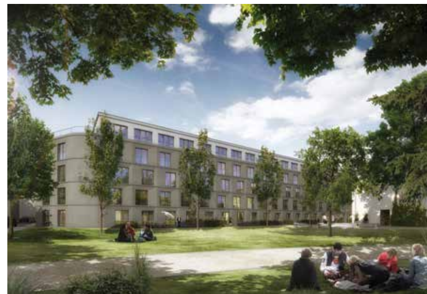
STUDENTENWOHNHEIM DARMSTADT, ERWEITERUNGSBAU © MKC
